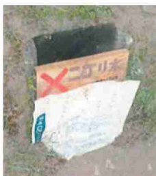
排水止水板は高めに設置する
